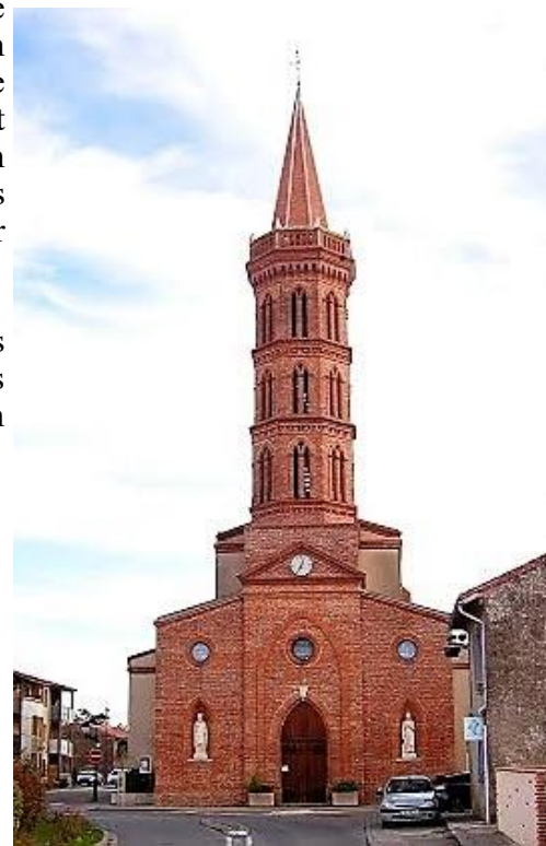
La façade de l'église
